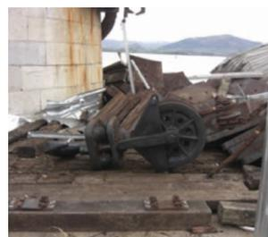
Se realiza una intervención inmediata en la retirada de los contrapesos y del resto de las estructuras metálicas en peligro de caída.
