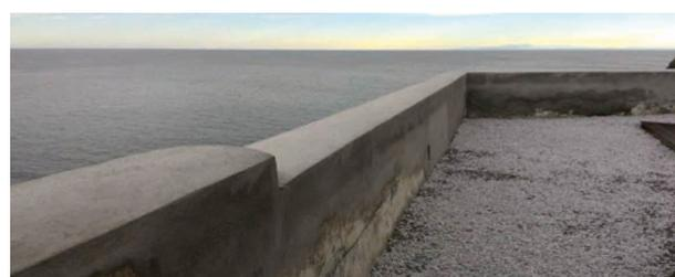
Zona del mirador retirado. Detalle del murete reconstruido.
