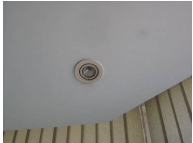
Figura 4.2.5 Lámpara halógena del edificio de Port Control
