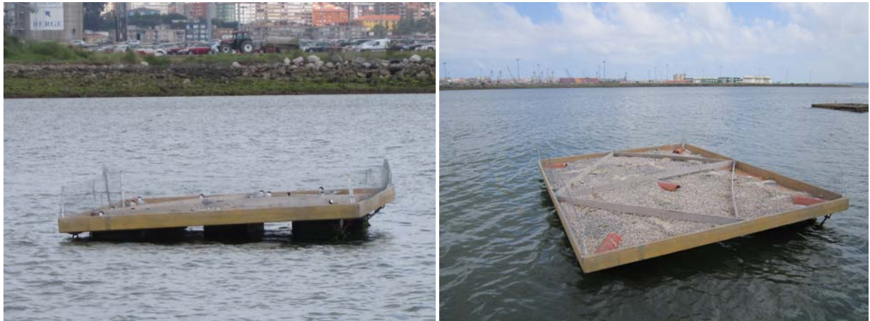
Figura 9.3. Isletas instaladas en la Dársena Sur de Raos
